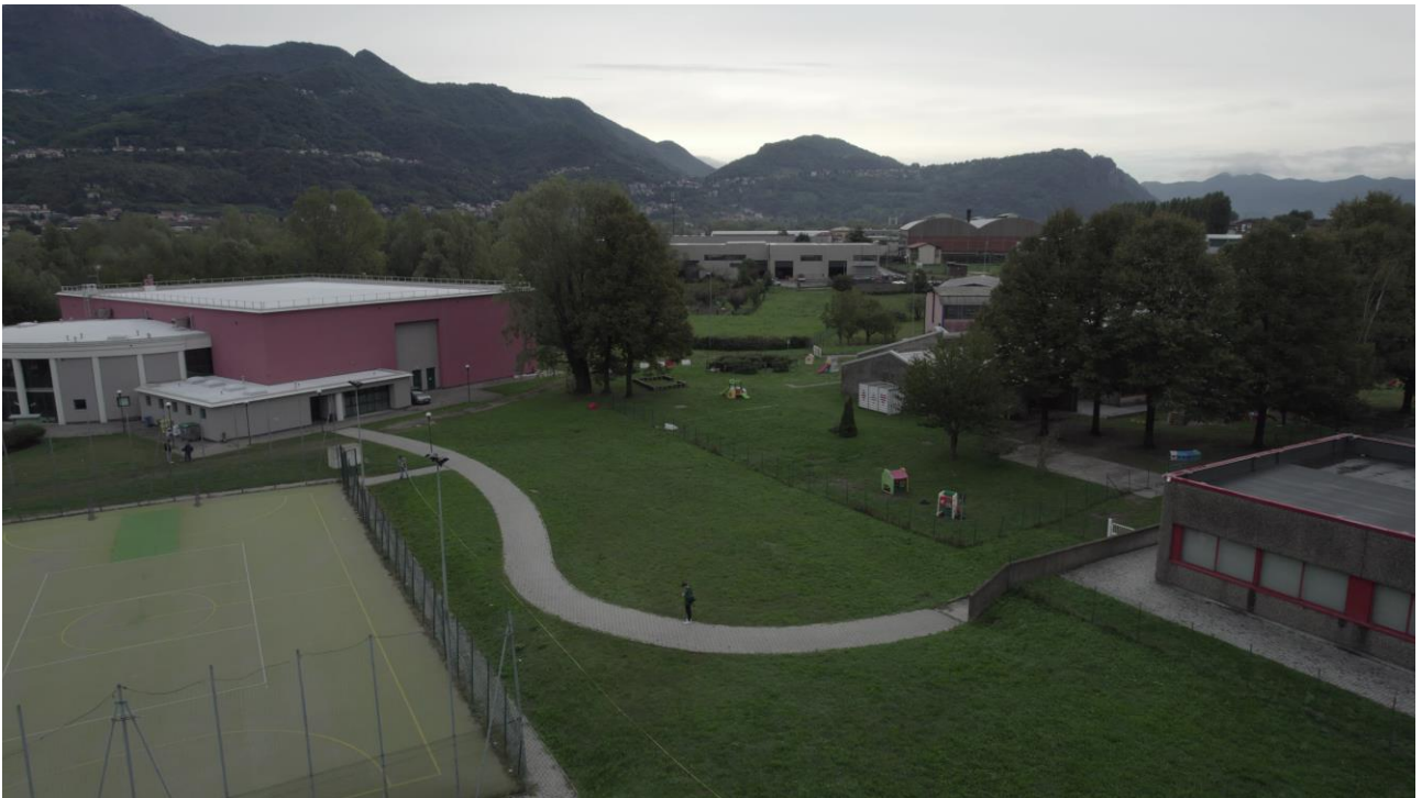
Foto aerea area in cui è prevista la costruzione
